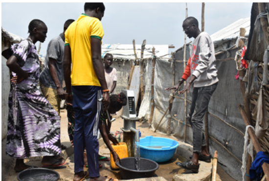
補修が完了して井戸水を確認している様子
