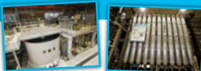
センター内のすべての排水を集め、「生物処理」「凝集・沈殿処理」「活性炭・ろ過」などの方法で処理し、放流および再利用します。当社が提供する排水処理技術の特長を集約し、ショールームの機能も持たせました。
