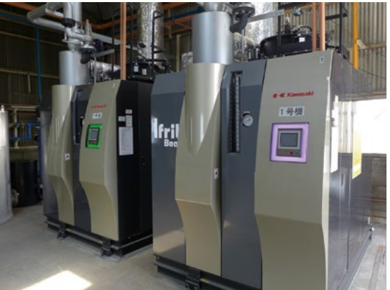
ボイラ管理の合理化により CO 2 排出量を削減
